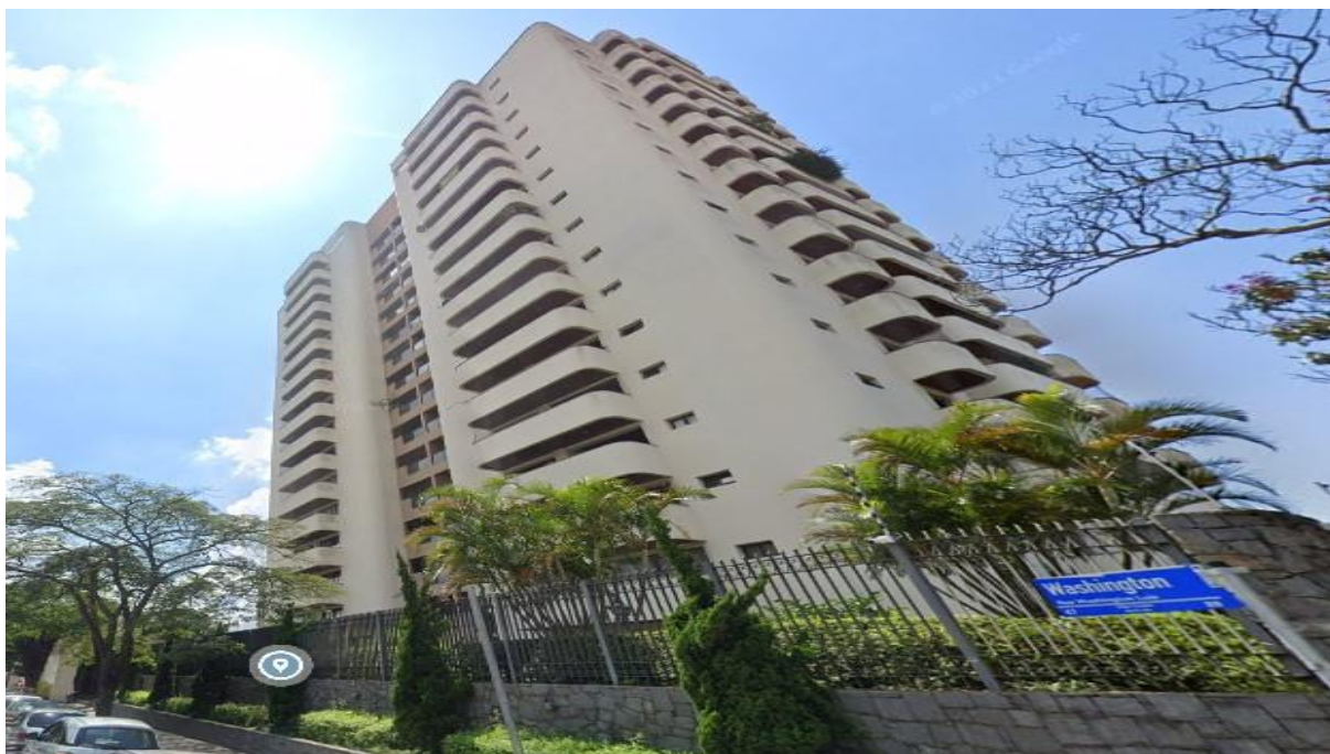
FOTO Nº 40 – DETALHE DA FACHADA PRINCIPAL DO EDIFÍCIO “VIA VENETO” LOCALIZADO À RUA WASHINGTON LUIZ, MUNICÍPIO DE SUZANO, CONFORME PLACA INDICATIVADA, DESTACANDO-SE O PADRÃO ARQUITETÔNICO ADOTADO, ALÉM DO PERFEITO ESTADO DE MANUTENÇÃO E CONSERVAÇÃO DA EDIFICAÇÃO.
