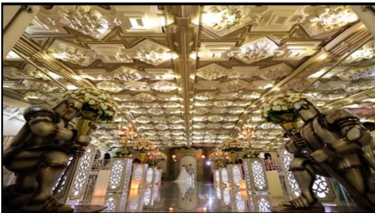
FOTO Nº 07 – DETALHE DO REVESTIMENTO DOS TETOS, EXECUTADO COM PAINÉIS DECORATIVOS, PRODUZIDOS E INSTALADOS INDIVIDUALMENTE, ALÉM DA ILUMINAÇÃO NOS PAINÉIS VERTICAIS.
