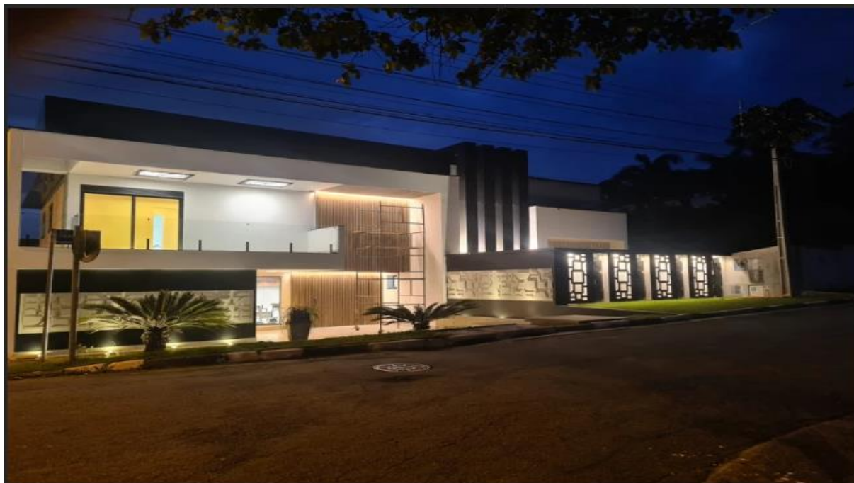
FOTO Nº 61 – DETALHE GERAL DA FACHADA FRONTAL, COM DESTAQUE PARA A ILUMINAÇÃO DECORATIVA.
