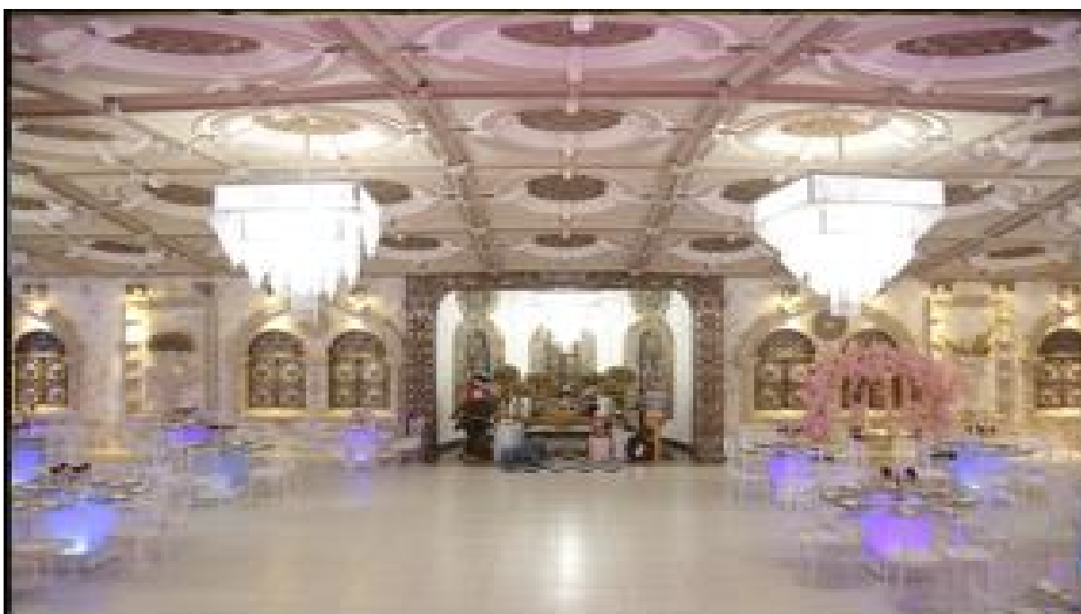
FOTO Nº 36 – DETALHE AMPLIADO DOS LUSTRES, COM DESTAQUE PARA O REVESTIMENTO DOS TETOS COM PAINÉIS DECORATIVOS MOLDADOS DE MODO ARTESANAL EM RESINA E INSTALADOS INDIVIDUALMENTE.
