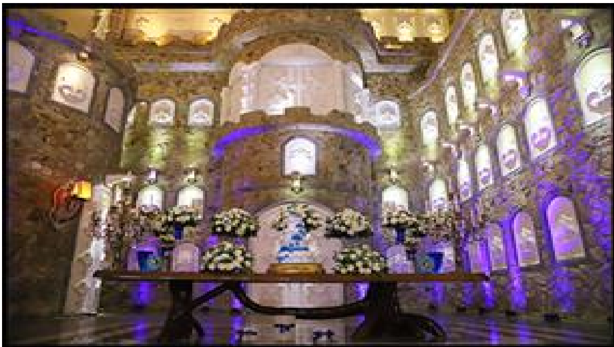
FOTO Nº 10 – DETALHE DO REVESTIMENTO DAS ALVENARIAS COM PEDRA NATURAL E, ILUMINAÇÃO DECORATIVA COMA UTILIZAÇÃO DE LAMPADAS DO TIPO LED.
