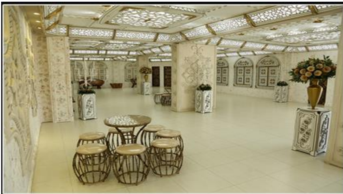
FOTO Nº 33 – DETALHE PARA OS REVESTIMENTOS, DO PISO COM A UTILIZAÇÃO DE PORCELANATO E DOS TETOS COM A UTILIZAÇÃO DE ELEMENTOS DECORATIVOS.
