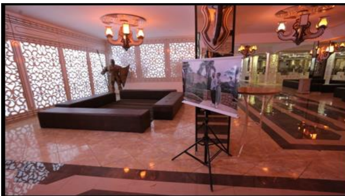
FOTO Nº 01 – SALÃO EXISTENTE NO CASTELO DE AVALON, DESTACANDO-SE O MOSAICO DO PISO EXECUTADO COM MARMORES E GRANITOS, ALÉM DOS VITRAUX, NA LATERAL ESQUERDA E NOS FUNDOS.
