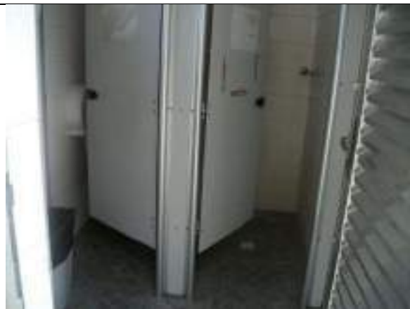
16 – Casa Motorista e Geradores
