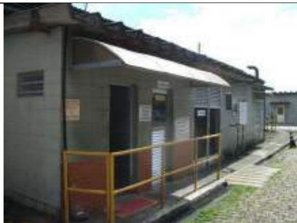
15 – Casa Motorista e Geradores
