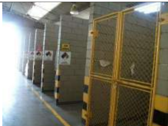
14 – Baías (Galpão Estoque)
